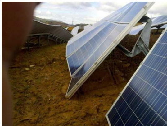
Zerstörte Unterkonstruktion und beschädigte Paneele
