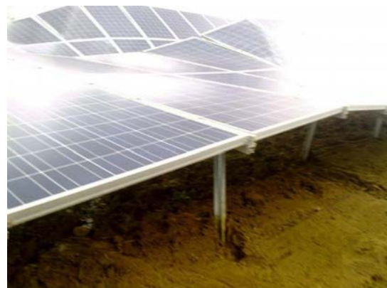
Zerstörte Unterkonstruktion und beschädigte Paneele
